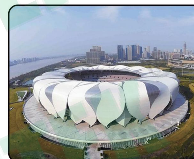
杭州奥体中心
